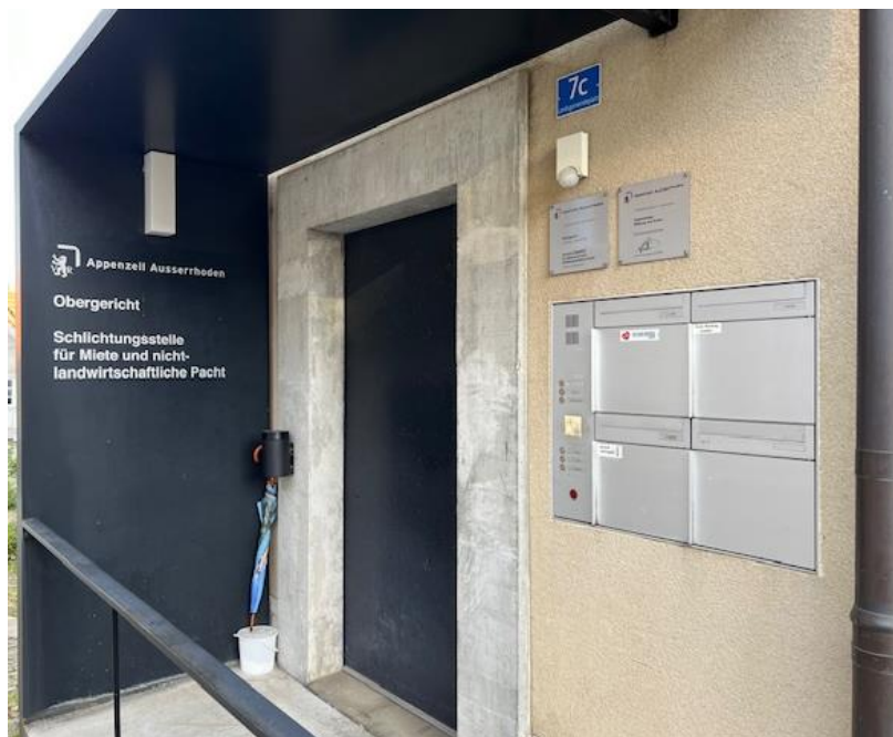
Abbildung 4: Eingang zum Obergericht auf der Südwestseite des Fünfeckpalasts.
